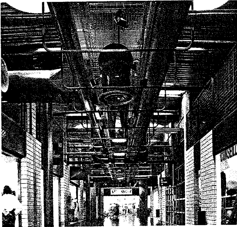
Hình 5.30: Ví dụ minh họa: Hệ thống điều hoà trung tâm được bố trí lộ thiên trong nội thất
