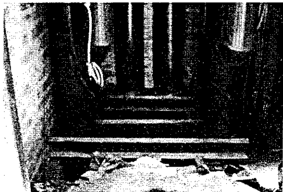
Hình 1.9: Hộp kỹ thuật cho ống cấp nước
