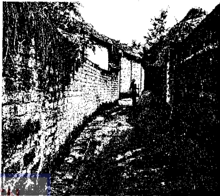
Hình 3.8: Vật liệu truyền thống nhà nền đất nện, tường đất, tường bằng đá ong, tường gạch nung trát vữa pha cát và vôi
