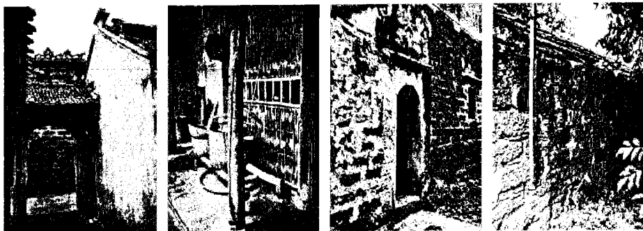
Hình 3.32: Tường vách bao quanh nhà xây bằng gạch, đá ong, đất, liếp tre...
