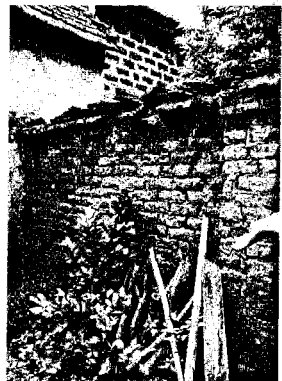
Hình 3.8: Vật liệu truyền thống nhà nền đất nện, tường đất, tường bằng đá ong, tường gạch nung trát vữa pha cát và vôi
